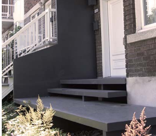
escalier et muret intimité
